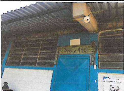
Foto 1: Reparación cable eléctrico
